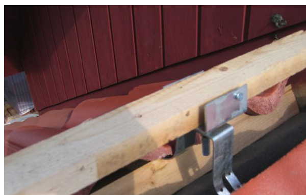
Monteringsbilde 6. Plasser mønekammen og fest denne i lektebroen. Legg deretter på plass møne- og valmetningsrull. Til slutt legges mønesteinen på plass. Du har nå fått en optimal, ventilert og rett møne.
