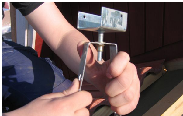
Monteringsbilde 1. Bend U-beina til egnet vinkel, det gjør du lett for hånd. Sett skruen i midstilling.
