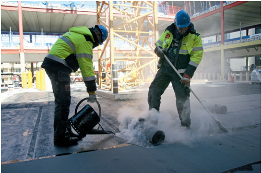
Figur 10: Klebing med varm asfalt
