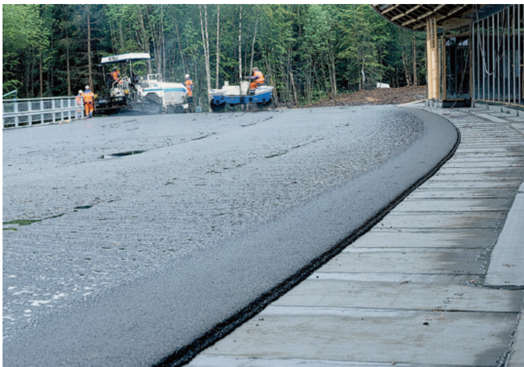
Figur 13: Parkeringsdekke med veiasfalt lagt direkte på sveisemembran
