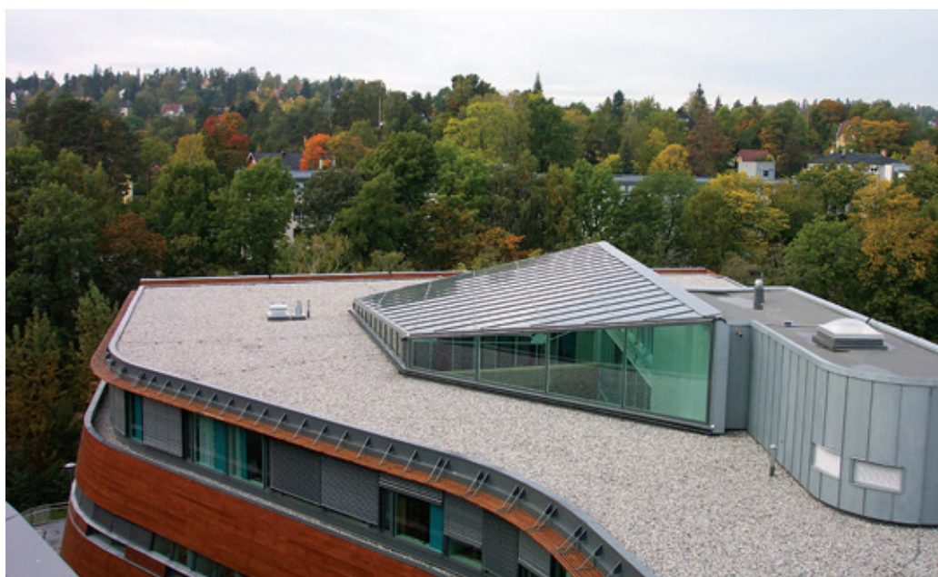
Figur 9: Eksempel på ballastering
