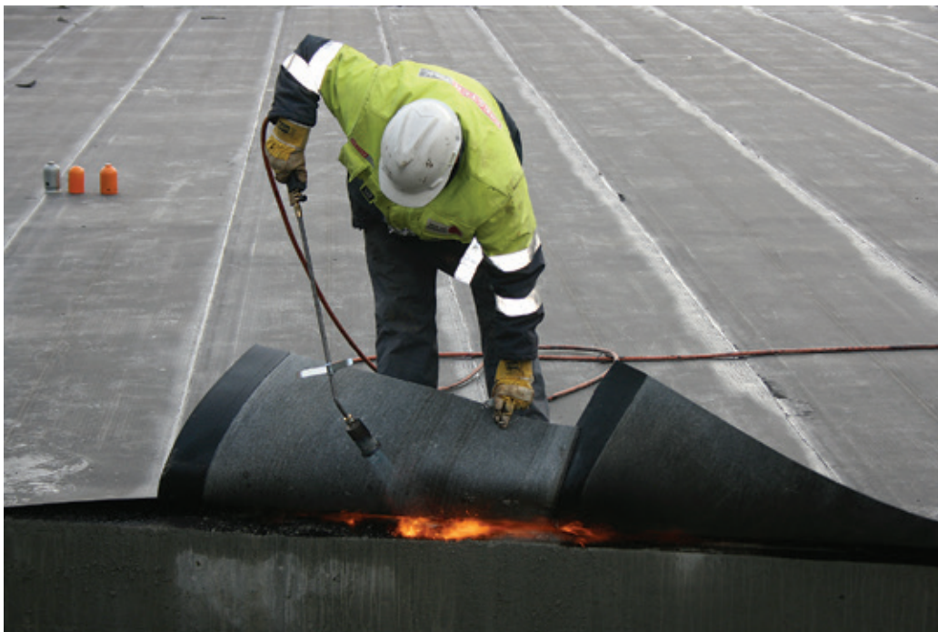
Figur 11: Helsveising av membran på parkeringsdekke
